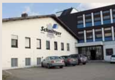
Budynek zarządu i magazynu Schnittger GmbH
